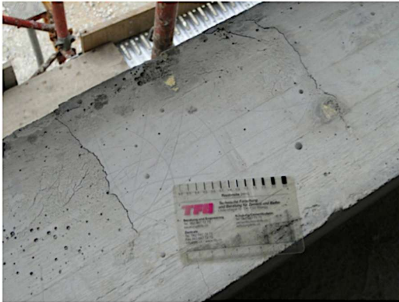
Photo 3 – Contrecoeur de fenêtre fissuré (sud)
